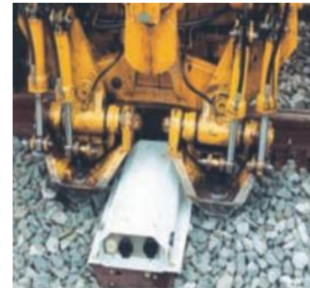
Компактный стальной брус с переводными устройствами заменяет собой шпалу и позволяет машинную подбивку балласта
